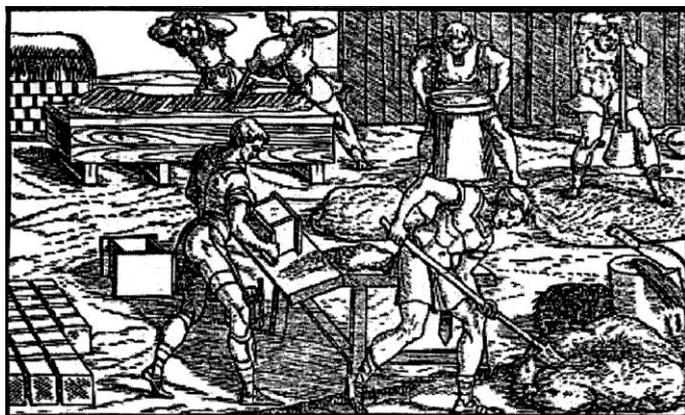
**Figure 5. Une équipe de travailleurs pétrissent l'argile avec la paille et préparent les briques crues à l'aide de moules (gravure de G. Rusconi 1590)**
