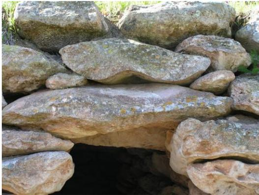
**Figure 4. Superposition de moellons sans mortier**
