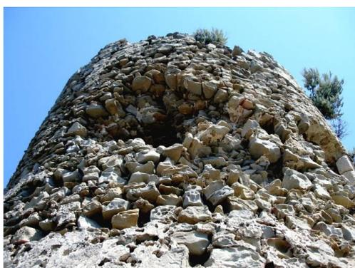
**Figure 16. Villasimius, Tour de Porto Giunco. Détail du mur, considérablement compromis par le phénomène d'érosion éolique.**
