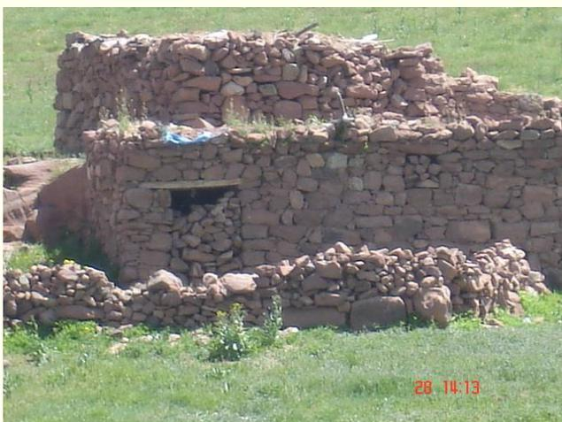
**Figure 4. Linteaux en bois à l'entrée d'un azib**
