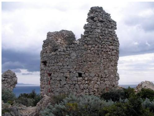
**Figure 5. Cagliari, Tour Sant'Elia. Détail de la façade où l'on peut apprécier la disposition des pierres selon 'chantiers', ainsi que la présence de trous de ponts de service, irrégulièrement disposés.**
