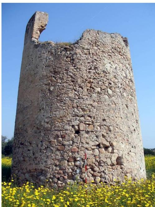
**Figure 9. Capoterra, Tour Su Loi. L'image met en évidence les 'chantiers', de hauteur plutôt régulière, correspondante à 49 cm.**
