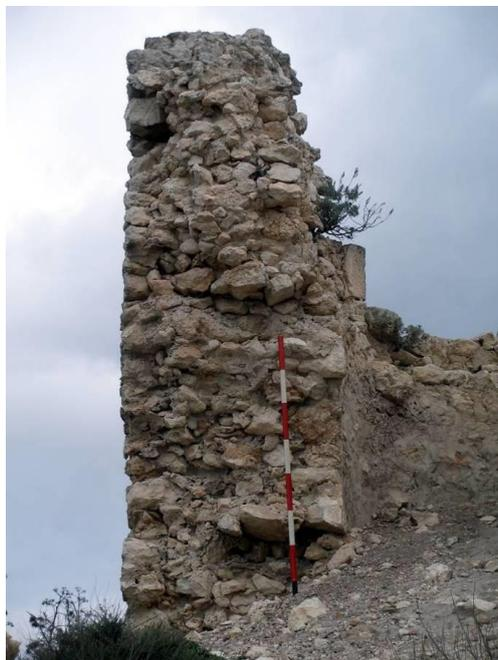
**Figure 4. Cagliari, Tour Sant' Elia. Section de mur, réalisé selon la technique d'arrangement avec noyau compacté.**
