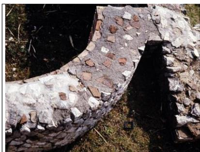
**Figure 3. Différences de solutions pour la protection des crêtes au caldarium de Sepino**
