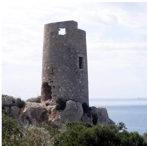
Figure 7. Cagliari, Tour su Perdusemi. La tour représente un cas sporadique où la fenêtre montre une corniche en blocs de pierres.
