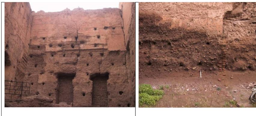
**Photo 1. Face ouest du Pavillon 2 (Groupe d'habitations) : Fissuration au niveau des murs des pavillons**
