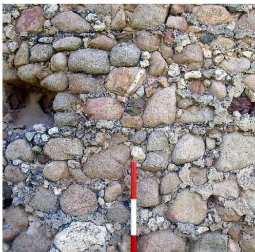
**Figure 2. Capoterra, Tour Su Loi. Détail de la disposition des 'chantiers', réalisés dans ce cas avec des cailloux de fleuve, de calibre variable.**
