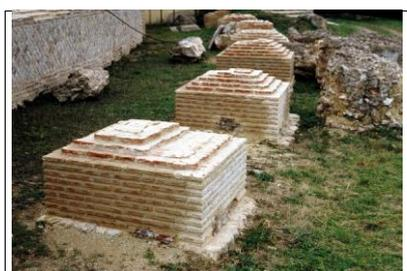
**Figure 6. Chaperons réalisés en briques et mortier à Larino**
