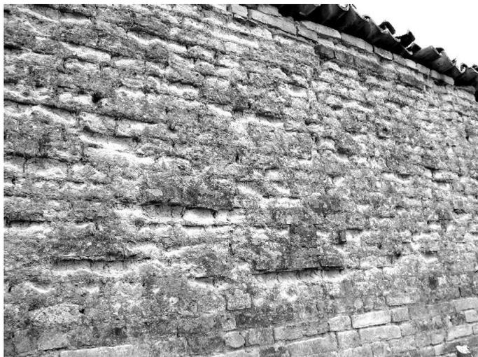
**Figure 2. Un mur rural de Vho (Piadena) Les briques crues se trouvent dans la partie centrale; les parties inférieures et supérieures sont fabriquées avec la brique cuite.**
