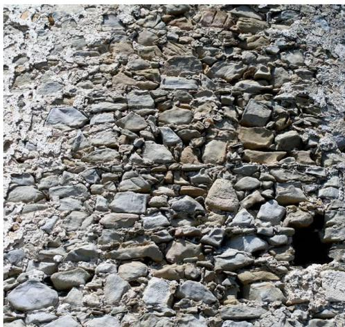
**Figure 14. Villasimius, Tour de Porto Giunco. Détail de la maçonnerie extérieure du mur, mettant en évidence un appareil réalisé avec des engrenages serrés.**
