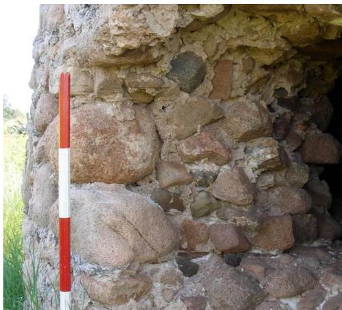
**Figure 3. Capoterra, Tour Su Loi. Section du mur, réalisé à travers la technique à sac.**
