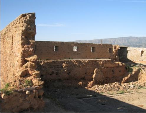
Fig 07 : surélévation de la ligne de couronnement
