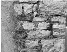
4. Iseo - Moellons de Majolica avec rognons de silex, placés sur le lit de carrière (à droite) et en délit (à gauche).
