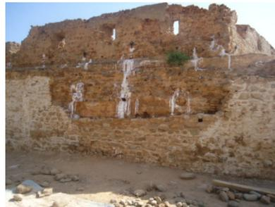
Fig 09 : utilisation d'entonnoir pour l'injection de mortier de chaux
