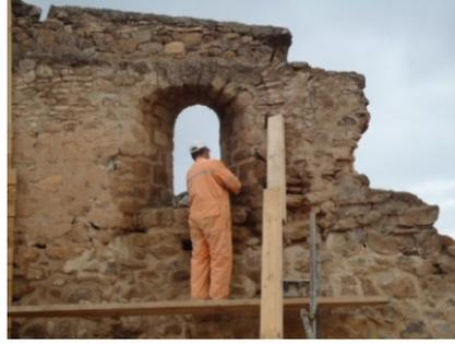
Fig 16:réfection de la ligne de couronnement fig 17 : reprise de contour des ouvertures
