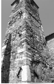
11. Sirmione – Clocher de S. Pietro bâti avec briques, galets et moellons de Scaglia aux arêtes
