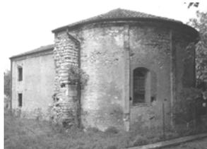
10. S. Eufemia della Fonte (Brescia) - Maçonnerie de moellons de Medolo et briques
