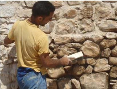
Fig 14 Rejointoiement des maçonneries :
