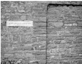
5. Varenna - Maçonnerie bâtie avec des moellons de calcaires de Moltrasio (plus épais) et de Varenna (plus mince)
