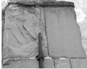
12. Iseo - Moellon de grès de Sarnico mis en oeuvre en délit et profondément altéré
