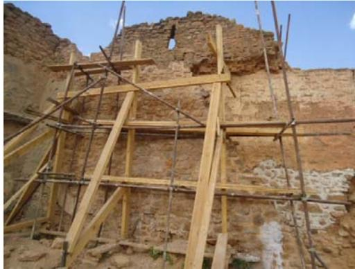
Fig 13 : Reconstruction après étaieage des fragments en maçonnerie instable
