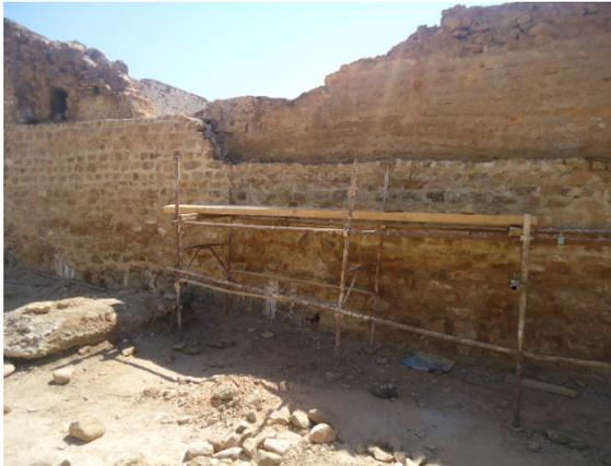
Fig 11 : dépose et reconstruction du mur de période française
