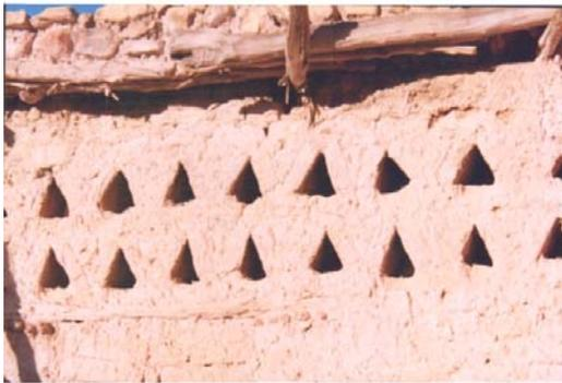
Fig.11: Ouvertures triangulaires disposées en Frise (Ph. Barrou, 1999).
