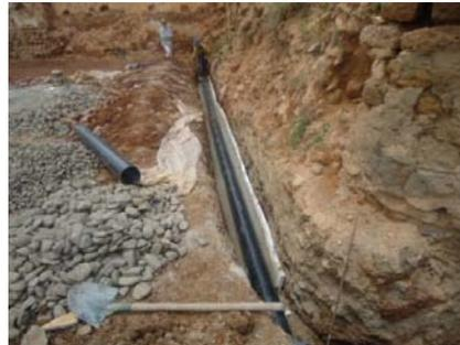
Fig 15 : Pose d'un drain périphérique Extérieur
