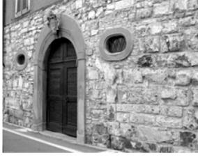
6. Riva di Solto - Maçonnerie bâties avec moellons de calcaire noir
