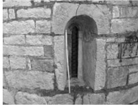
3. Canzanica - Moellons de Majolica pour la fenêtre et la maçonnerie.
